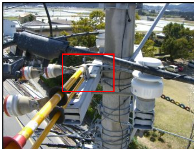
【 シール取り付け状況 】
