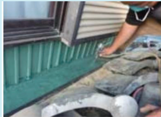
構造物の補修
