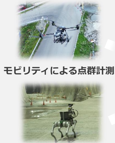
トンネル建設現場
